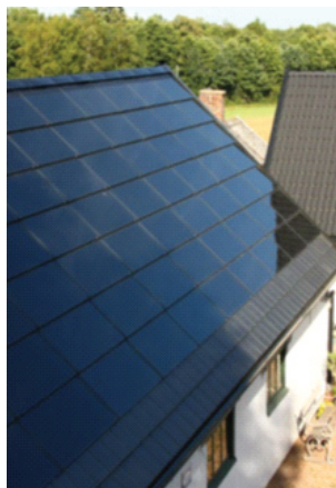
Roof monterad på en Skånelänga. Produkten läggs direkt på läkten (rekommenderat läktavstånd 620-640 mm) och fungerar både som solcell och som taktäckningsmaterial. Produkten är gjord för att tåla väder och vind och för att gå på, vid eventuell service. Nominell effekt är 85W +/- 10 % per enhet.
