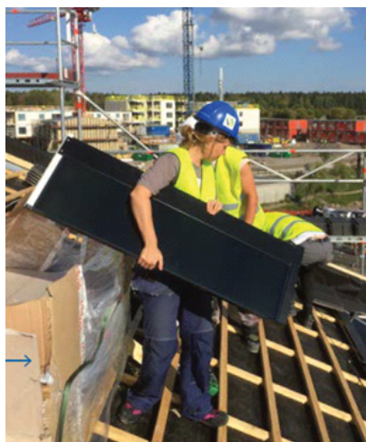
ShingEL är en solcellsmodul som läggs på läkten och är helt kompatibel med betongpannan Carisma från Benders, se bilden. Det innebär att solcellspannan kan läggas på övervägande delen av taket men t.ex. runt skorstenar eller längs kanterna där det kan bli för trångt med en hel ShingEl-panna, kan Carismapannor läggas i stället.
