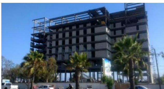
Ett hotell under byggnation
