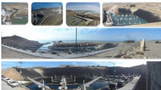
En hamn under byggnation
